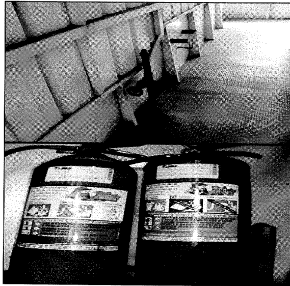
Imagem 14: Equipamento de incêndio
